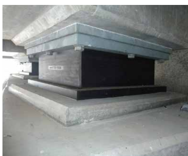
コンクリート桁 設置例
