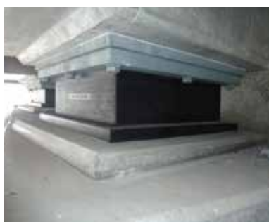
コンクリート桁 設置例
