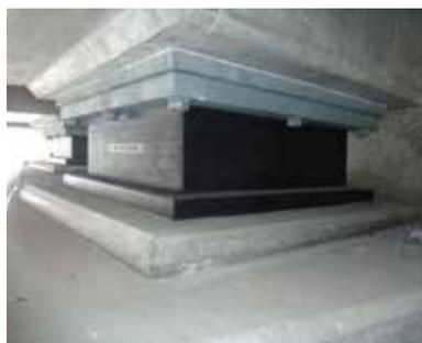
コンクリート桁 設置例
