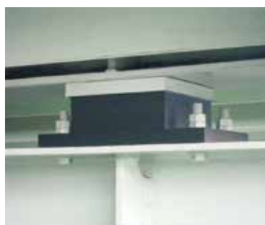
鋼桁 設置例
