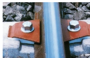
バネクリップの先端ばね定数試験 (財) 鉄道総合技術研究所にて実施
