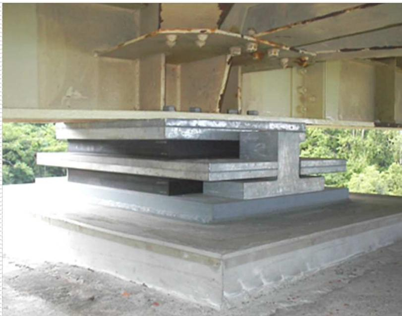
サイドブロックを上支承まで立ち上げることで、橋軸直角方向への移動を固定する
