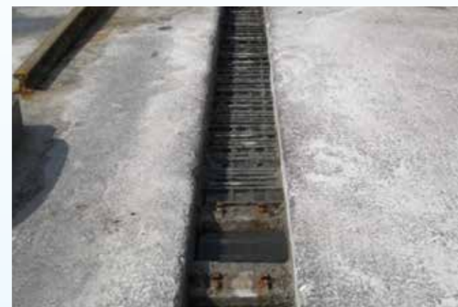
2 既設レール撤去・はつり状況
