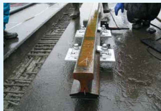
3 締結装置取付状況
