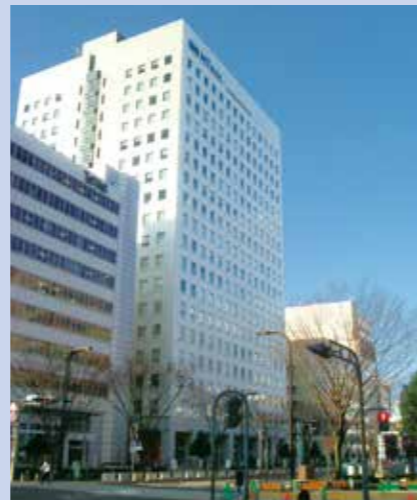
仙台MTビル
