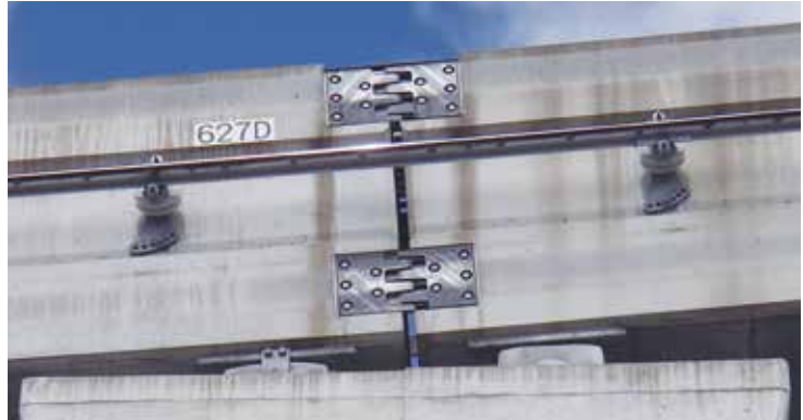
モノレール軌道桁用落橋防止装置
