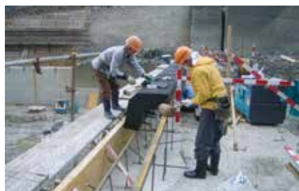
コーナー部 (2分型) 設置状況
